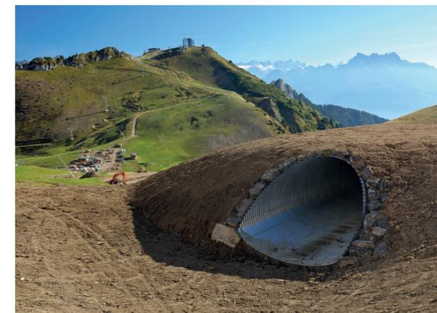
Les travaux ont inclus la réalisation d'un passage souterrain de 68 mètres de long, destiné à faciliter l'accès au half-pipe durant les Jeux et permettre l'exploitation après l'événement de la zone située entre le slopestyle et le half-pipe.
