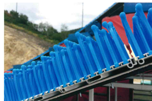
En lieu et place de neige, les tremplins seront recouverts de « dry snow », de très fines tiges en plastique ayant l'aspect de cotons-tiges.
