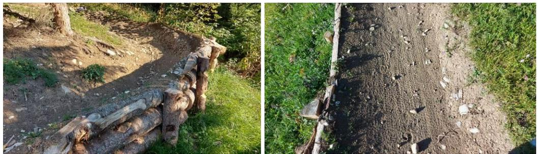
Figure 13. Exemples d'une stabilisation bien intégrée d'une piste VTT à Leysin
