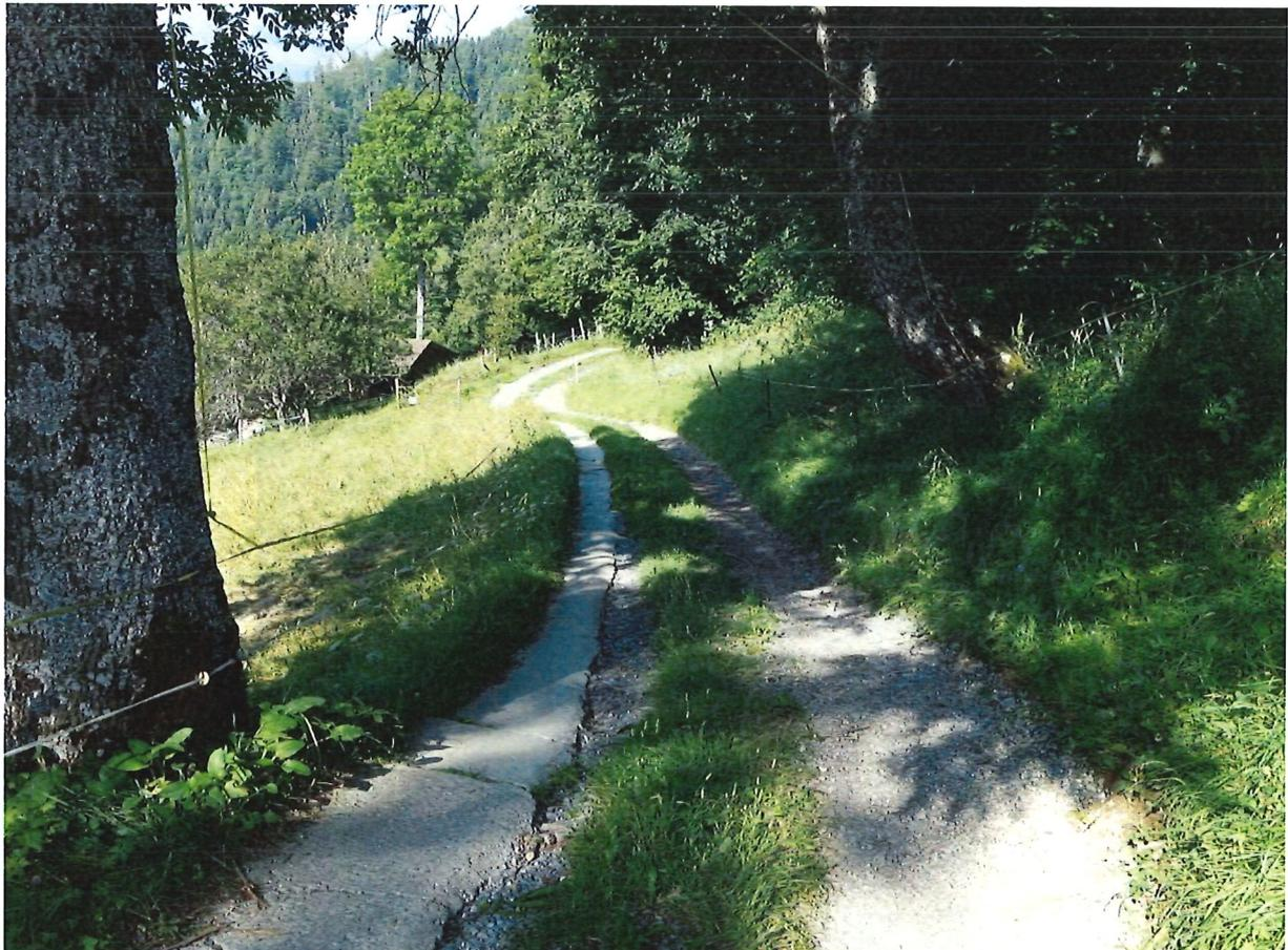
Photo 6 : Chemin de Ponty – Revêtement mixte en grave avec ponctuellement une bande de roulement aval bétonnée.
