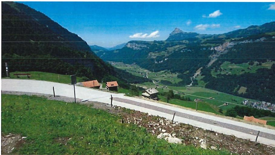
Fig. 3 : Exemple de virage bétonné sur toute la largeur (les roues arrière des machines ne balayent pas la même trajectoire que les roues avant).
