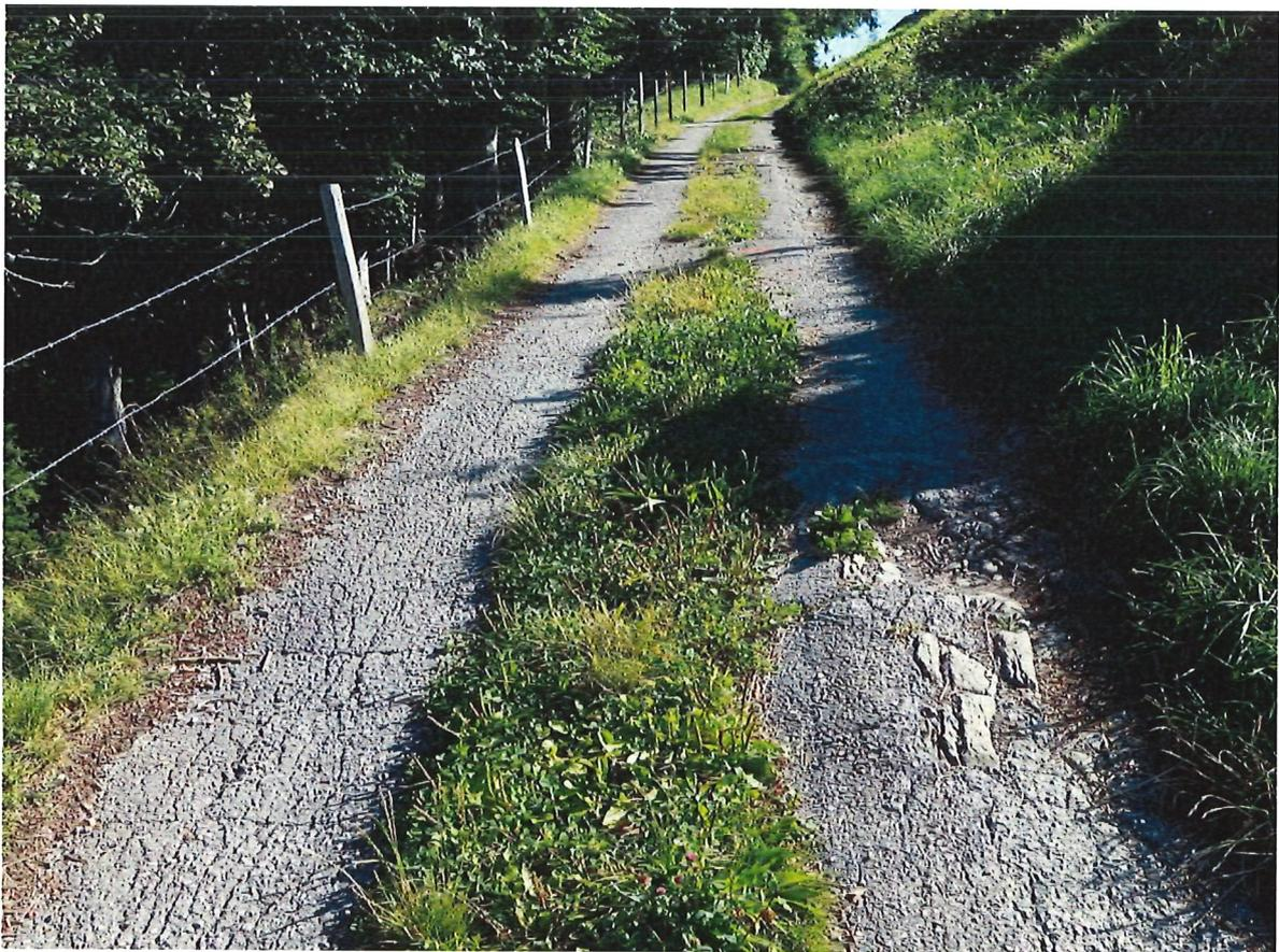
Photo 2 : Chemin de Ponty – Tronçon avec bandes de roulement en bitume (DP n°1076).
