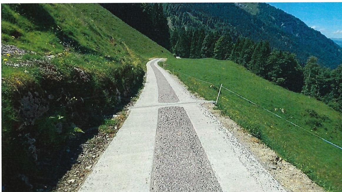
Fig. 2 : Exemple de bandes de roulement bétonnées avec une finition anti-dérapante et renvois d'eau bétonnés.
