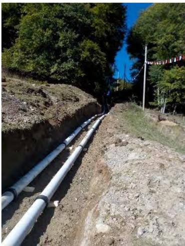
Le tracé des conduites est maintenant bien défini et a été relevé à l'aide d'un GPS. La conduite de Coussy a été raccordée et mise en service. Les pressions maximums aux points de raccordement aval sont de 61 bars pour la conduite de Coussy et de 46 bars pour celle des Deux-Rochers.
