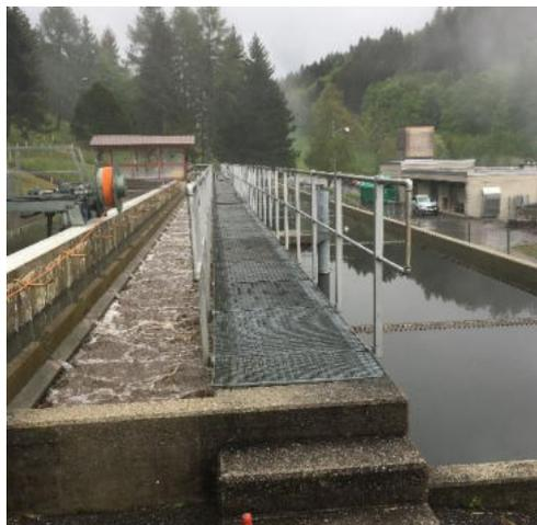
Figure 2-3 : STEP existante, bassin de boues activées et décanteur secondaire.
