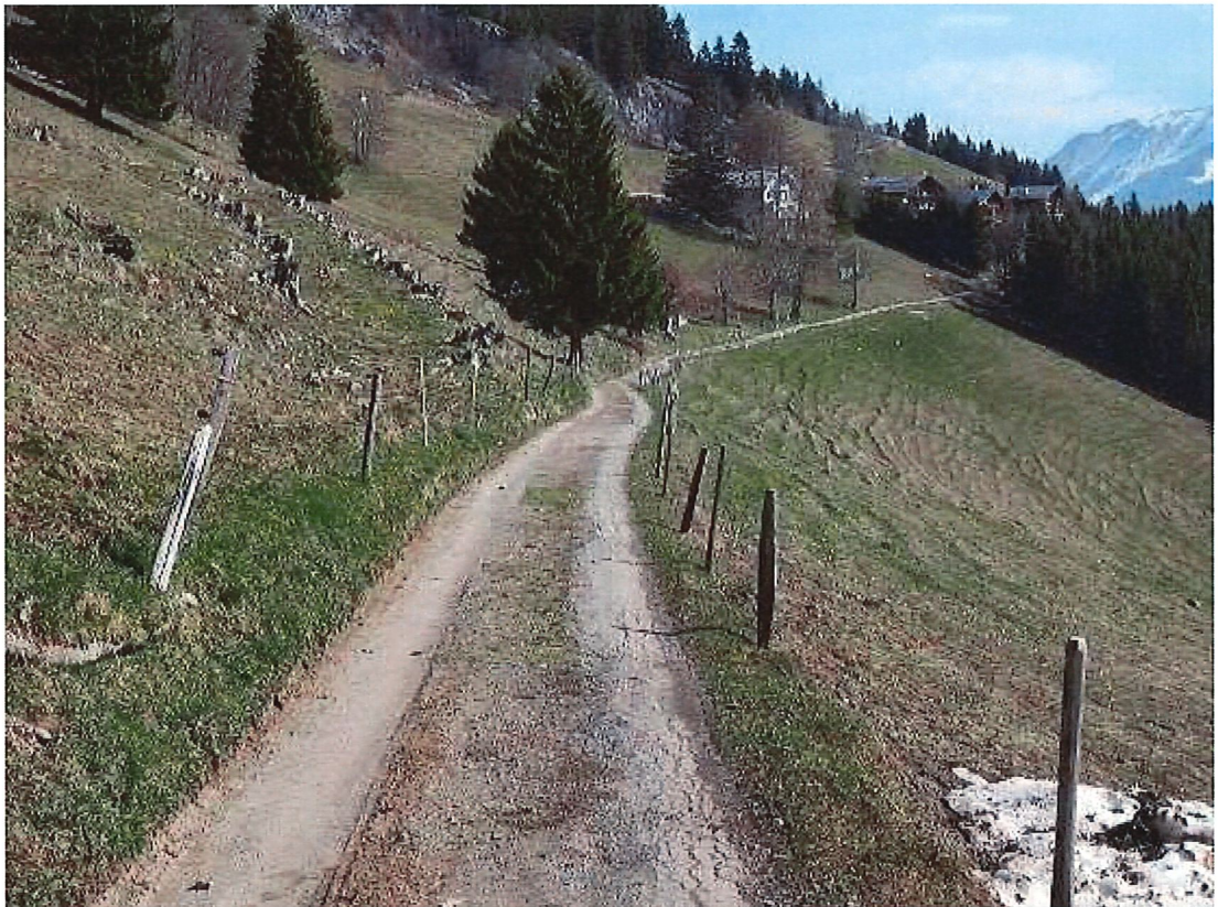
Photo 1 : Chemin de l'Horizon (chemin n°16), premier tronçon.
