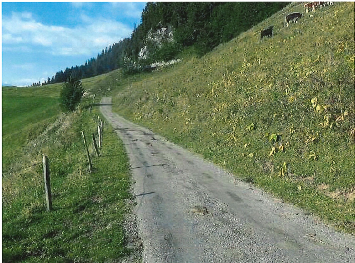
Photo 4 : Chemin n°5, secteur avec revêtement en bon état.
