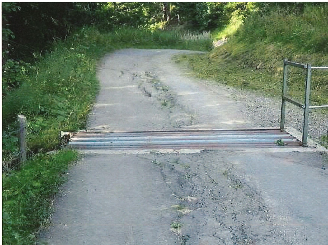
Photo 7 : Chemin n°5, 2 tronçons de 12 m à stabiliser.
