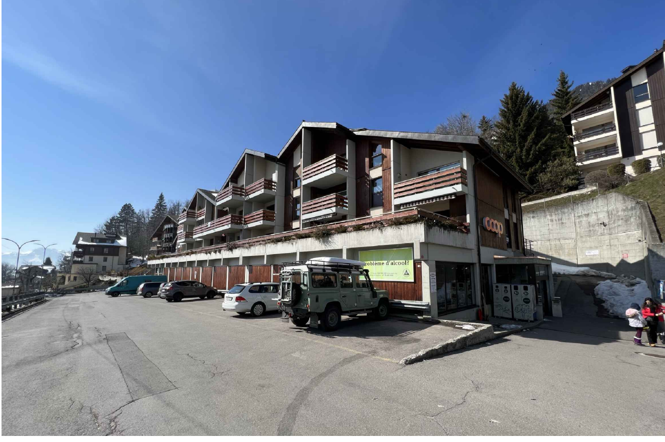
FACADE EXISTANTE (SUD-EST)
